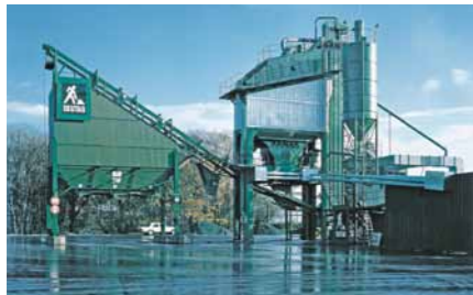
德国沥青混合料搅拌站
